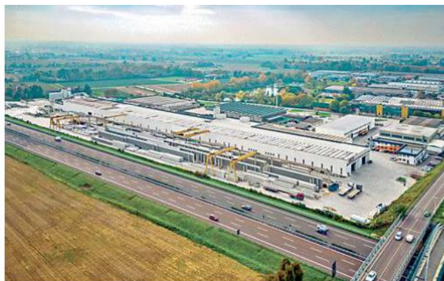
Lo stabilimento Tesi System a Casale sul Sile
