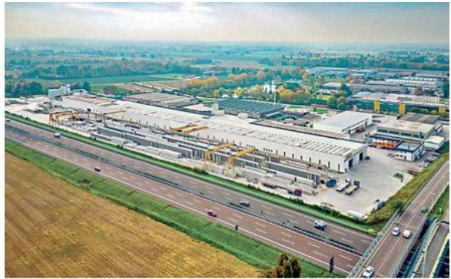
Lo stabilimento Tesi System a Casale sul Sile
